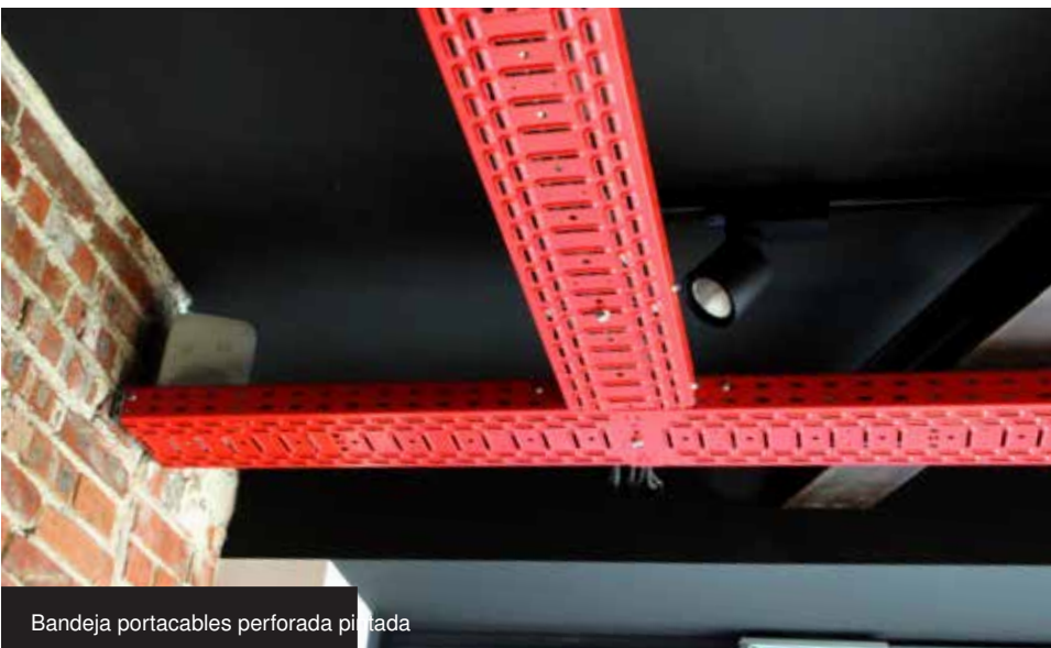
Bandeja portacables sin perforar pintada Brezelmuseum, Erdmannhausen
