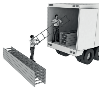
Imagen 1 Descarga de las bandejas portacables
